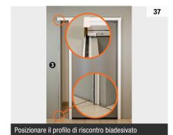
inserendolo tra muro e guida (vedi immagine). Se la superficie non permette la tenuta del biadesivo, fissare il profilo mediante viti.
