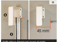
Staffa attacco frontale lato gruppo di spinta. Utilizzare il profilo di riscontro come dima per il posizionamento verticale della cuffia. Misurare 50 mm dallo spigolo del muro per il posizionamento orizzontale della cuffia, come da immagine.
