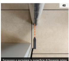
Sgrassare e asciugare la superficie di fissaggio prima di incollare il biadesivo: la completa adesione si ottiene dopo almeno 24 ore.
