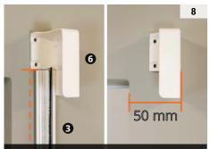
Staffa attacco frontale lato cassonetto. Utilizzare il profilo di riscontro come dima per il posizionamento verticale della cuffia. Misurare 50 mm dallo spigolo del muro per il posizionamento orizzontale della cuffia, come da immagine.
